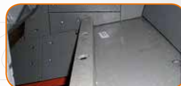
Ochrona taśmociągu głównego
