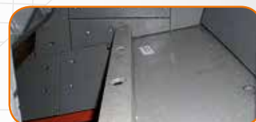
Ochrona taśmociągu głównego
