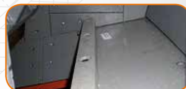
Ochrona taśmociągu głównego
