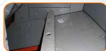
Ochrona taśmociągu głównego
