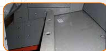
Ochrona taśmociągu głównego
