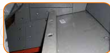
Ochrona taśmociągu głównego
